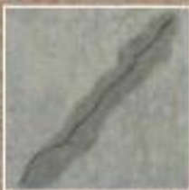
Watervoerende scheuren
